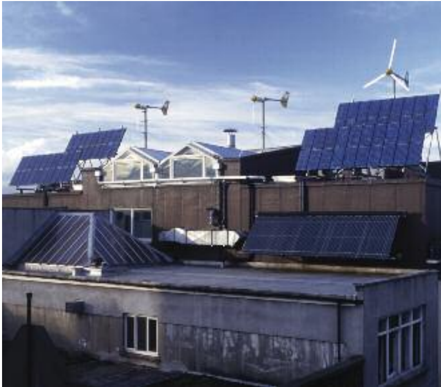
Tejado de edificio que incorpora diferentes tecnologías de energía renovable: térmica, fotovoltaica y minieólica.
