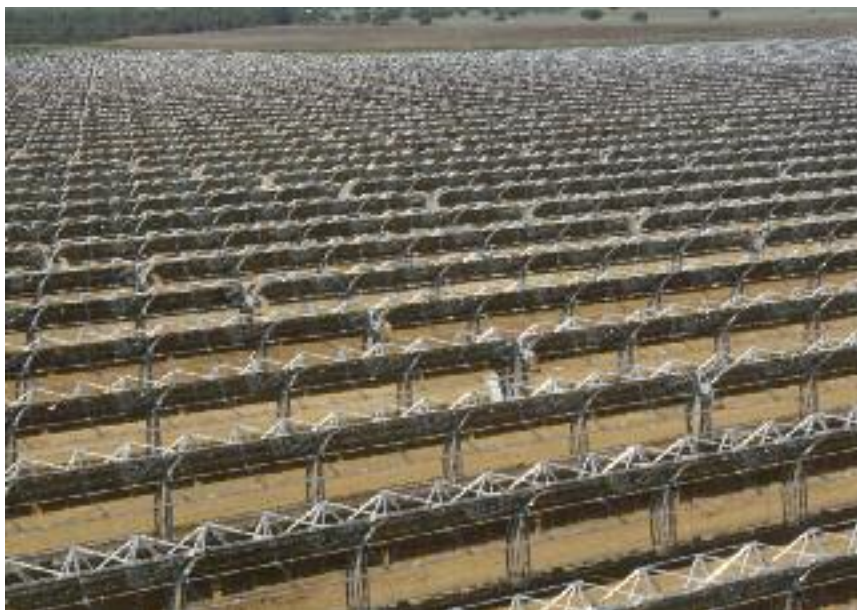
Panorámica de una planta solar termoeléctrica de cilindro parabólico.
