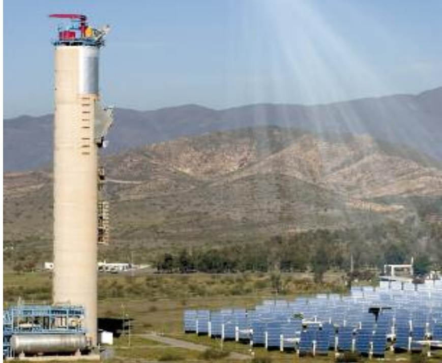
Vista general de una instalación de central de torre.
