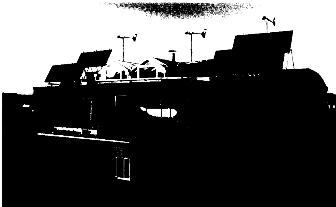
Tejado dublinés con térmica fotovoltaica y minieólica.
