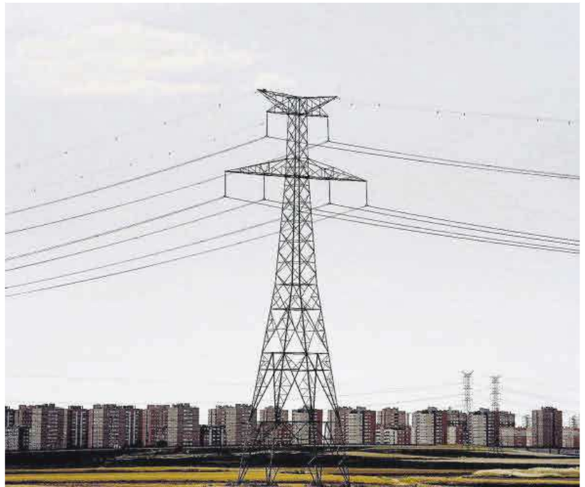
Torres eléctricas en un solar situado cerca de numerosos bloques de viviendas, en Madrid.
